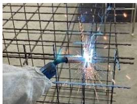
写真1 スポット溶接
