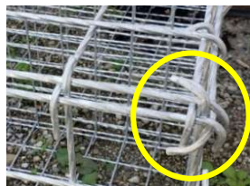
写真2 曲げ加工
