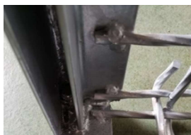
写真3 扉用フレーム溶接
