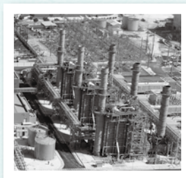
3 ガス火力発電所が2019年12月に完工
