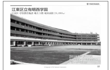
竹中工務店設計施工で2018年に開校した東京都江東区の有明西学園の校舎。燃エンウッドを使った耐火木造建築で、東京五輪の会場の多いエリアなので、木の魅力を世界に発信する役割も持つ。
