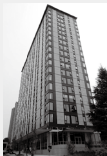
木造で建てられたブリティッシュコロニア大学の学生寮(18階建て)。写真提供: 日本CLT協会
