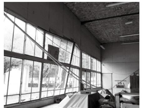
窓枠・天井梁が破損した熊本工業高校 建築科実習棟
