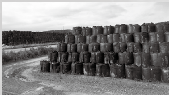
仮置き場には、除染廃棄物を入れたフレコンバッグが積み上がっている
