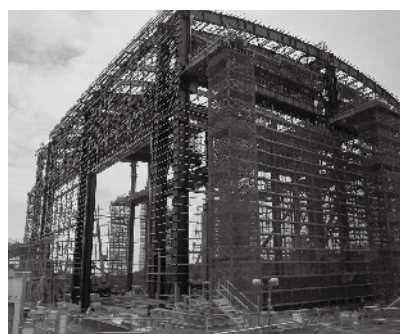
楡葉遠隔技術開発センター建設現場
