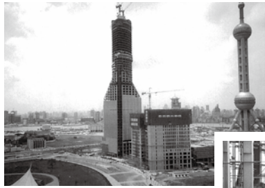
工事中の中国銀行上海ビル 右端は東方明珠(上海TV塔)
