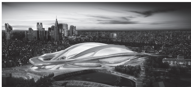
オリンピック・スタジアム外観イメージ図 新国立競技場基本構想国際デザイン・コンクールにおける最優秀賞受賞作品
