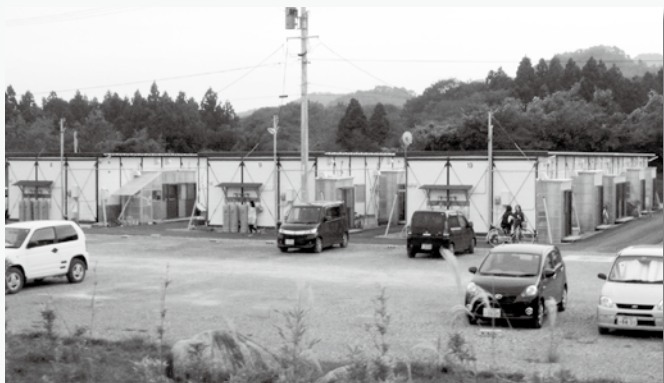
仮設住宅。コミュニティを壊さないように地区ごとに入居している。
