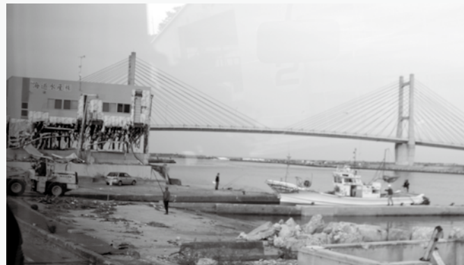
松川浦大橋。夜になるとライトアップされる観光スポットだった。
