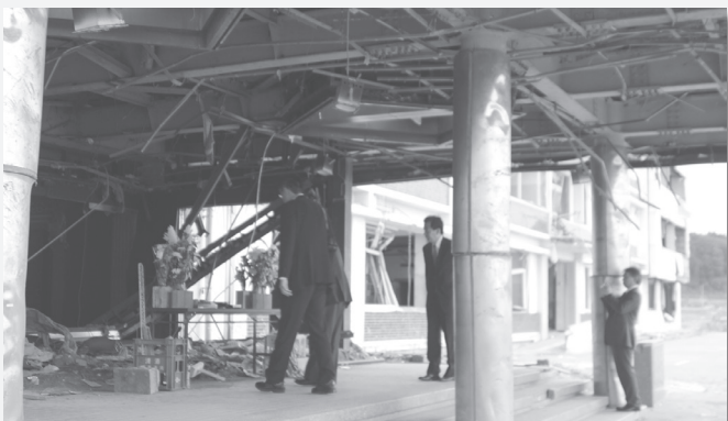
市役所。3Fまでにいた人はすべて流され、屋上に逃げた人もくぼしまで水に浸かった。コンクリートの建物の1Fにはお花とお線香が供えられていた。
