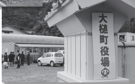
▼現在はプレハブの仮設庁舎で業務を続ける。
