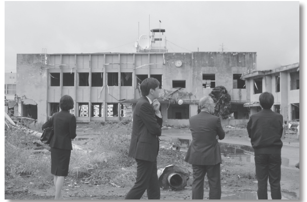
被災した大槌町役場。地震発生当時、古い建物の中にいることは危険として、役場前で防災対策会議をしているところで突如津波が押し寄せ、多くの職員が命を落とした。
