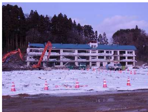
被災した校舎の撤去工事の様子(1月16日事務局撮影)。新校舎は2015年3月に完成する予定。
