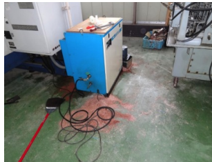
破損によるオイル漏れ
