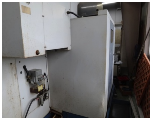
壁にぶつかり破損(背面)②
