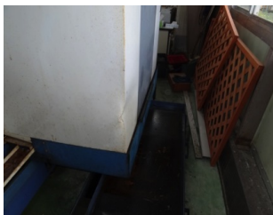
壁にぶつかり破損(背面)①
